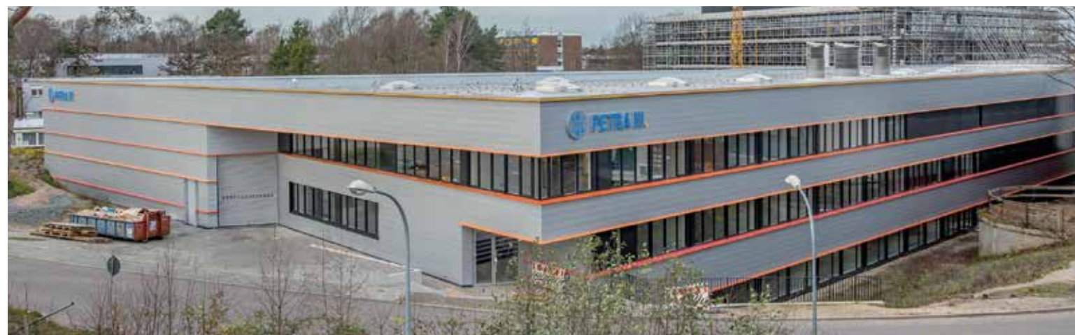
Experimentierhalle Ost der PETRA III-Erweiterung. Bild: Edgar Weckert, DESY
