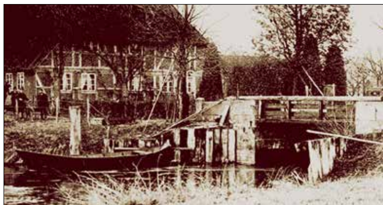
Abbildung 6: Keine Kammerschleuse, sondern nur ein Stauwehr, dessen Klappe alle paar Tage bei genügend hohem Wasserstand geöffnet wurde und die Durchfahrt freigab. Die Boote fuhren dann mit dem Wasserschwall abwärts oder wurden mühsam von Land aus gegen den Strom gezogen.
