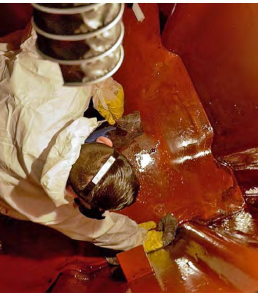
**Im Stahltank:** Der Monteur reinigt den Tankraum und überprüft die Wandung auf Beschädigungen und Korrosion.
