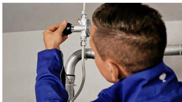
**Abpumpen und prüfen:** Der Monteur pumpt das vorhandene Heizöl bis auf die Bodenphase ab. Unten: Prüfung und Einstellung des Antihebertentils.
