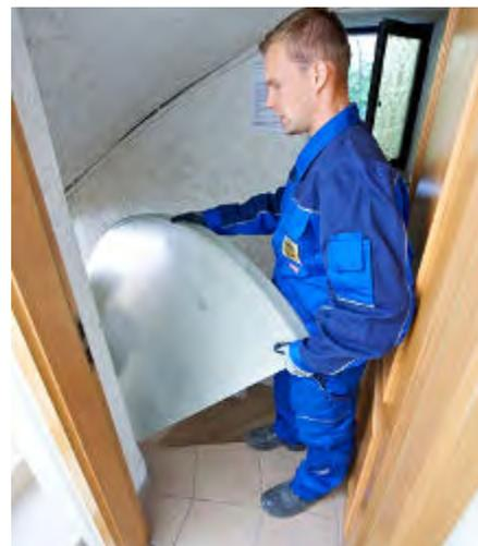
**Raumwunder Öltank:** Moderne Öl-Vorratsbehälter sind platzsparend, lassen sich gut durch schmale Türen und enge Treppenhäuser tragen – und im Keller dann zu Batterietanks kombinieren.
