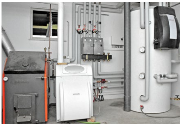
Hybridheizung mit Scheitholzkessel, effizienter Öl-Brennwerttechnik und 1.000-Liter-Pufferspeicher.
