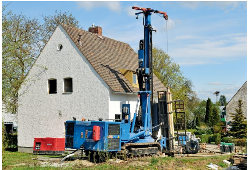
Schweres Gerät: Bohrungen zur Installation einer Erdsonden-Wärmepumpe sind nicht nur sehr aufwendig und erfordern zahlreiche Genehmigungen. Sie sind zudem teuer.
