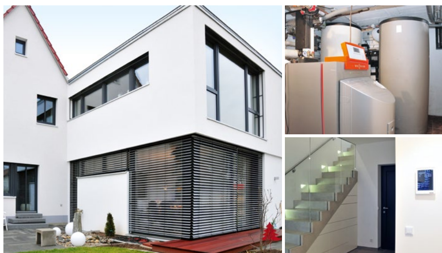
Schmuckstück: Aus dem rückständigen Vorkriegsbau wurde ein modernes Zweifamilienhaus. Ein Öl-Brennwertkessel, Typ Viessmann Vitoladens 300-T, sorgt im Alt- und Neubau für Wärme.
