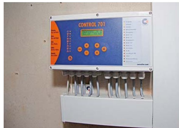
Eine Öl-Brennwert-Solarheizung senkte im Verbund mit Wärmedämmung den Primärenergiebedarf um 72 Prozent.
