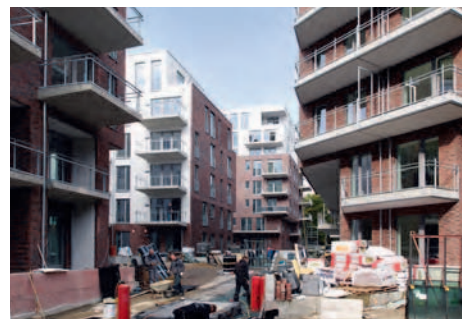
Verschattung auf Gegenseitigkeit: Extrem geringe Fassaden-Abstände in der Thadenstraße. Wer hier wohnt, muss sein Sonnenbad im nahe gelegenen Wohlers Park nehmen.
