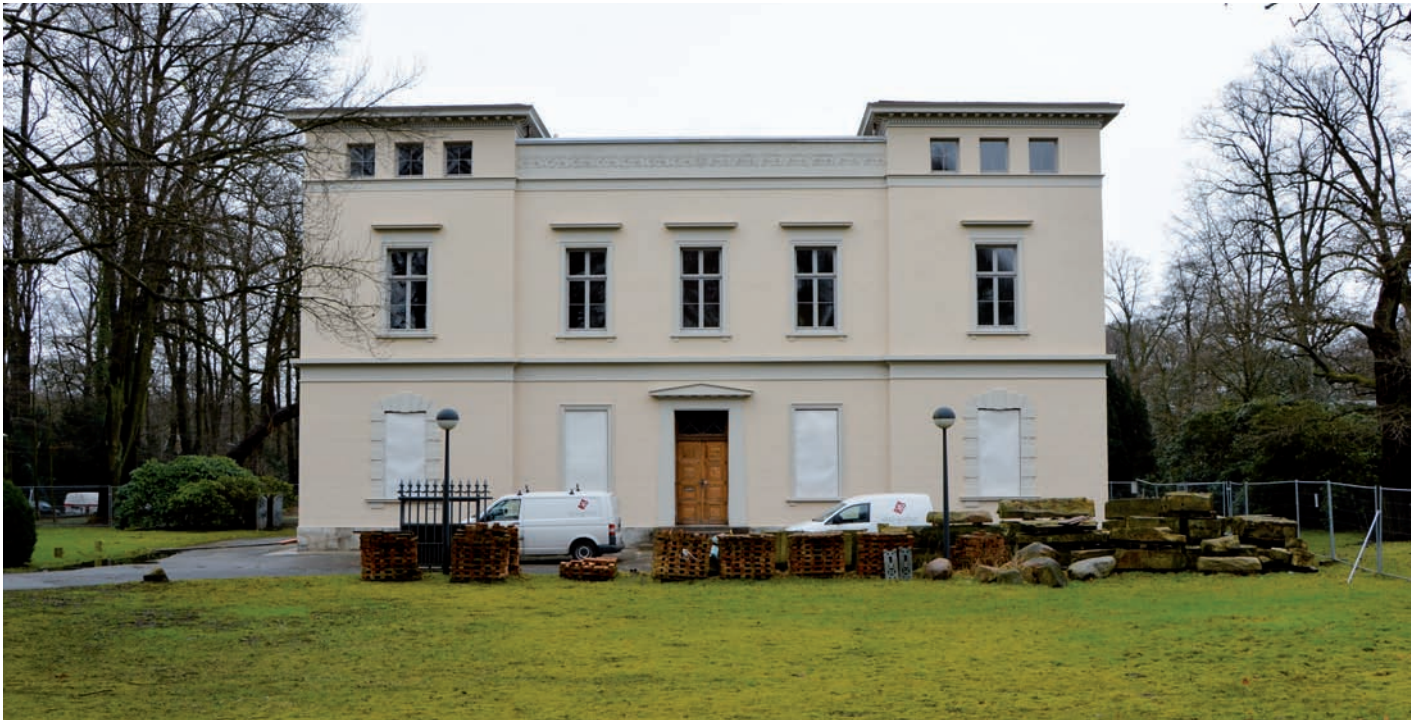
Der Katharinenhof ohne Gerüst, Ende Februar, von der Nordwestseite
