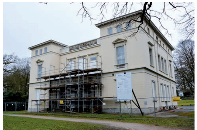
Die rückwärtige Fassade mit Resten des Gerüsts
