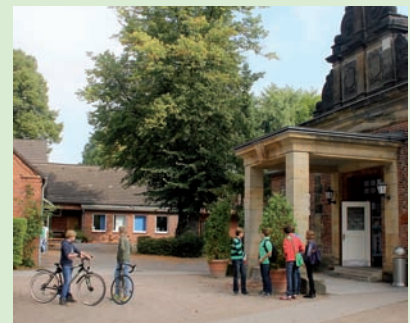
Schulhof im Jenisch-Gymnasium
