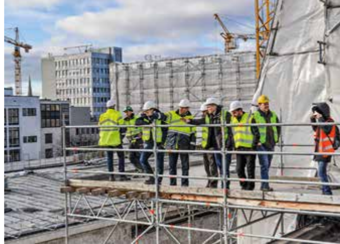
Exkursion von Kölner Studierenden des trialen Ausbildungsgangs auf eine Baustelle.
