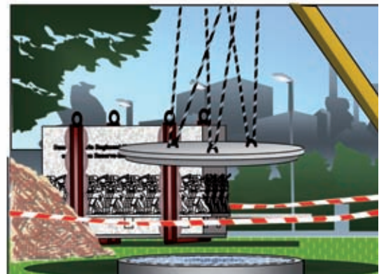
Bau des zweiten Teils des neuen Fundamentes
