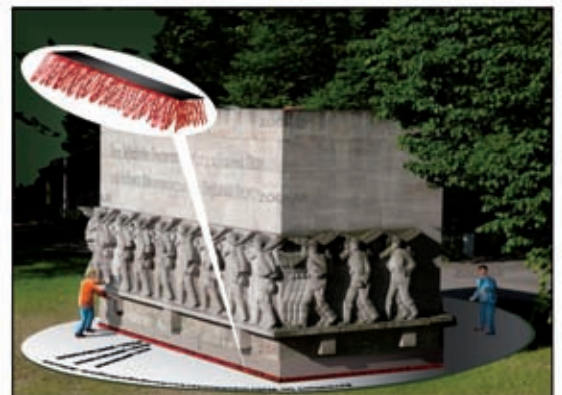
Rote Bürsten füllen den Spalt zwischen Denkmal und Bodenplatte
