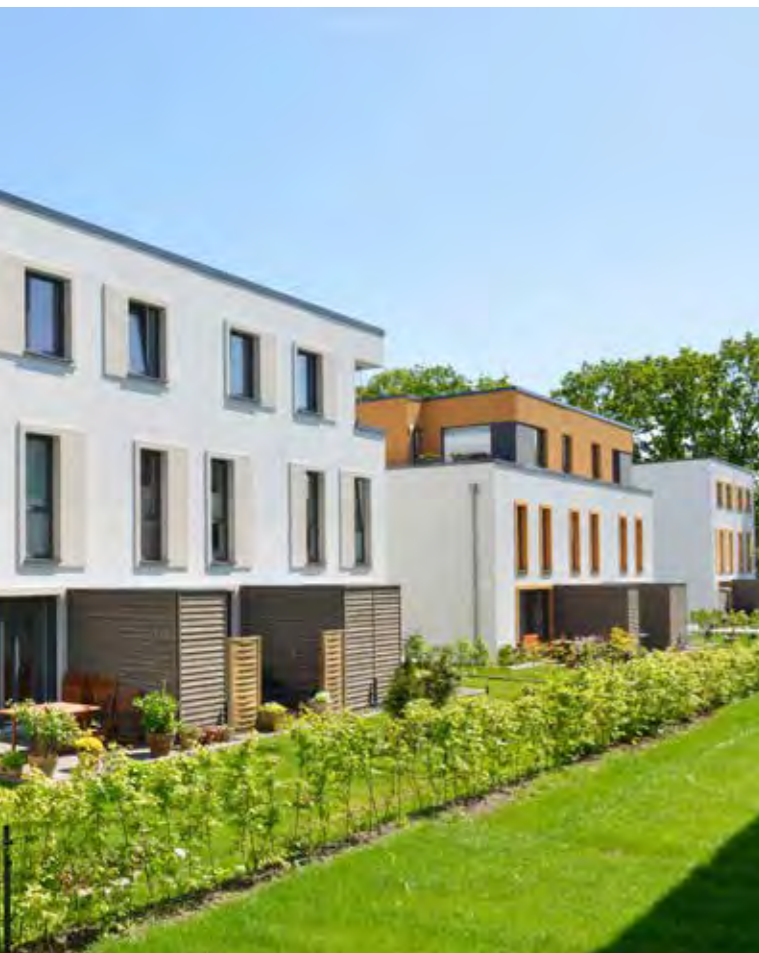
Foto: raumwerk architekten / Martin Kunze
