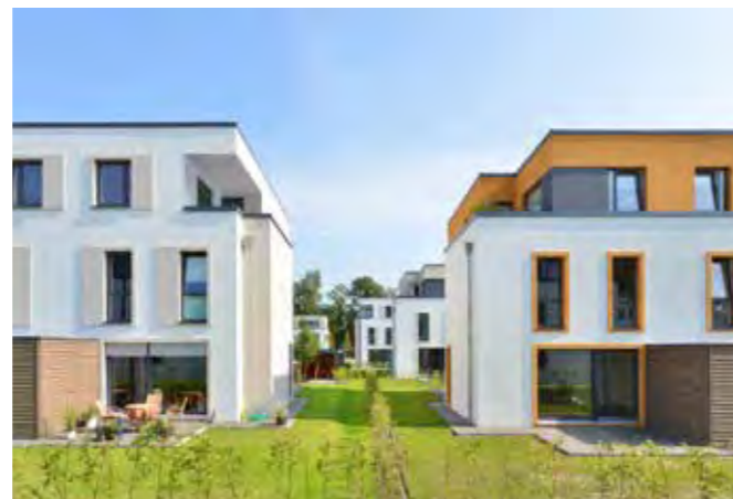
Foto: raumwerk architekten / Martin Kunze
