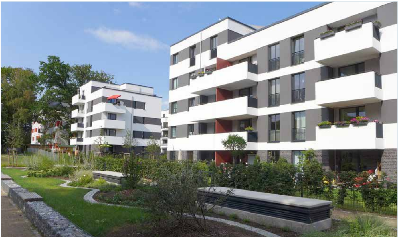
Neubau SAGA GWG Parkquartier Friedrichsberg
