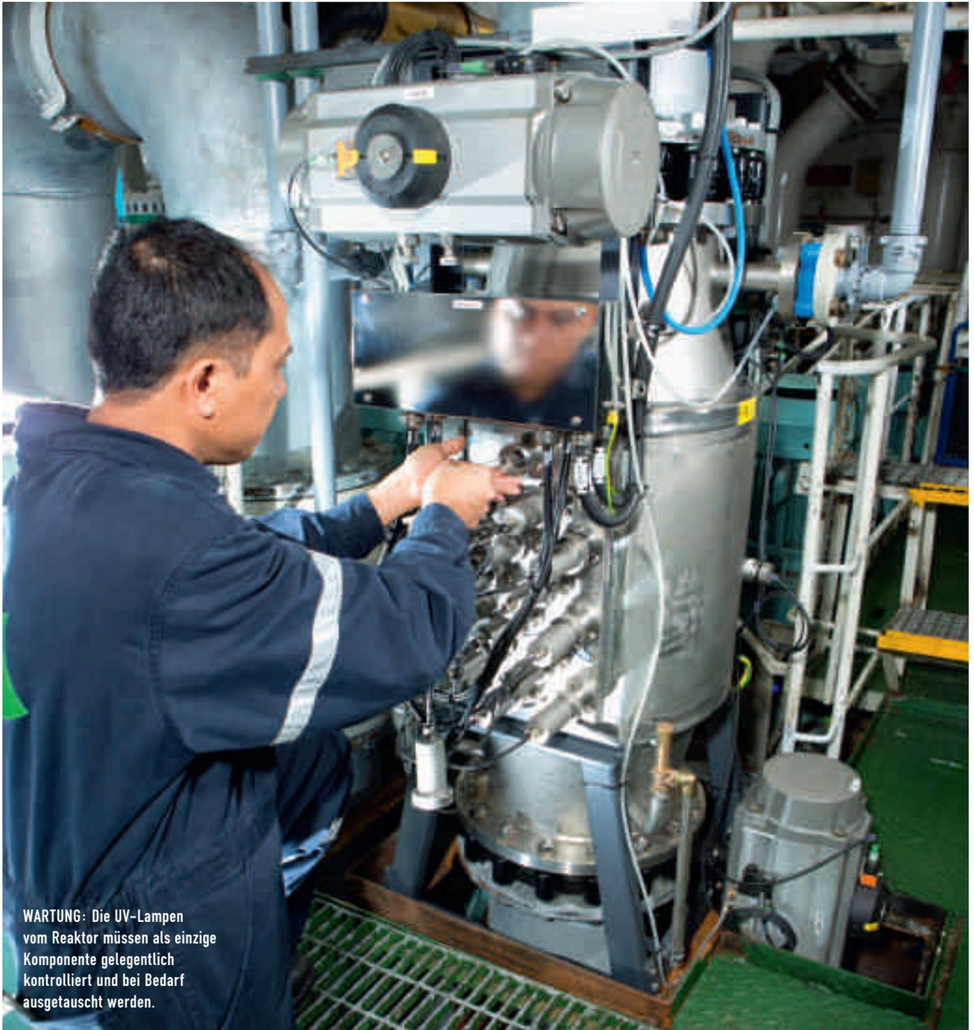
**WARTUNG:** Die UV-Lampen vom Reaktor müssen als einzige Komponente gelegentlich kontrolliert und bei Bedarf ausgetauscht werden.
