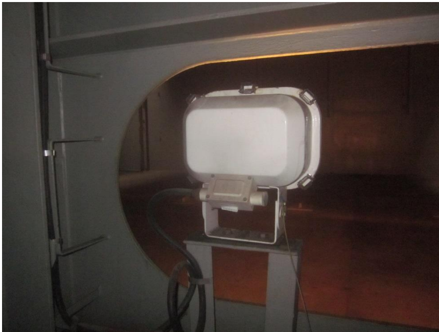
Abbildung 7: Zentraler Hauptstrahler auf dem Quergang
