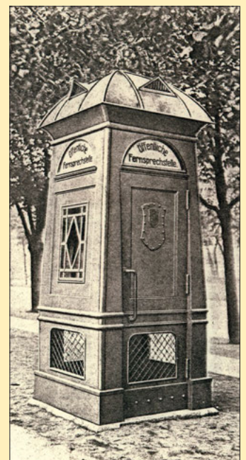
Zu den Lieferprodukten der Firma Petersen gehörten viele spezielle Entwicklungen für den Post- und Telegrafenaufbau, wie wettersichere Kabelverzweiger, Linienverzweiger, Kabelendverschlüsse in verschiedenen Ausstattungen und auch die oben abgebildete Fernsprechkabine.
