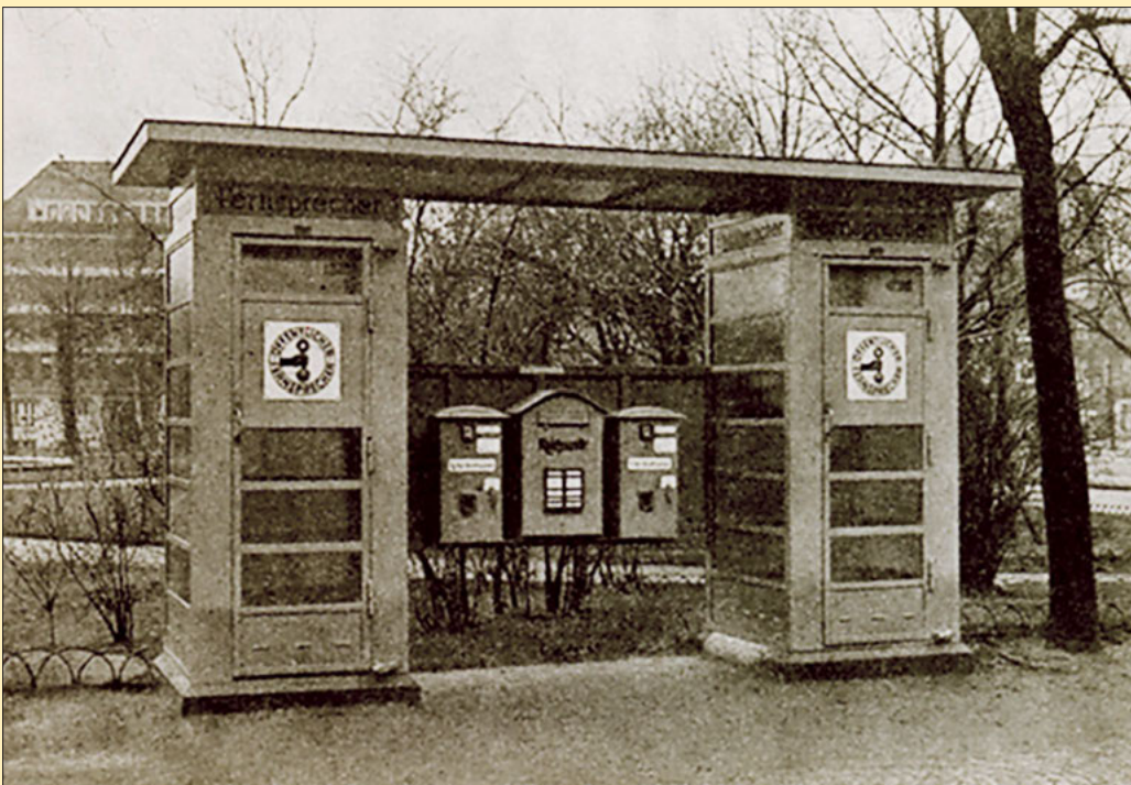
Das Foto stammt aus dem Jahr 1924 und zeigt ein so genanntes stummes Postamt, eine Anlage die Petersen konstruierte. Zwischen den Fernsprechkablen waren ein Briefkasten und Briefmarkenautomaten angebracht.
