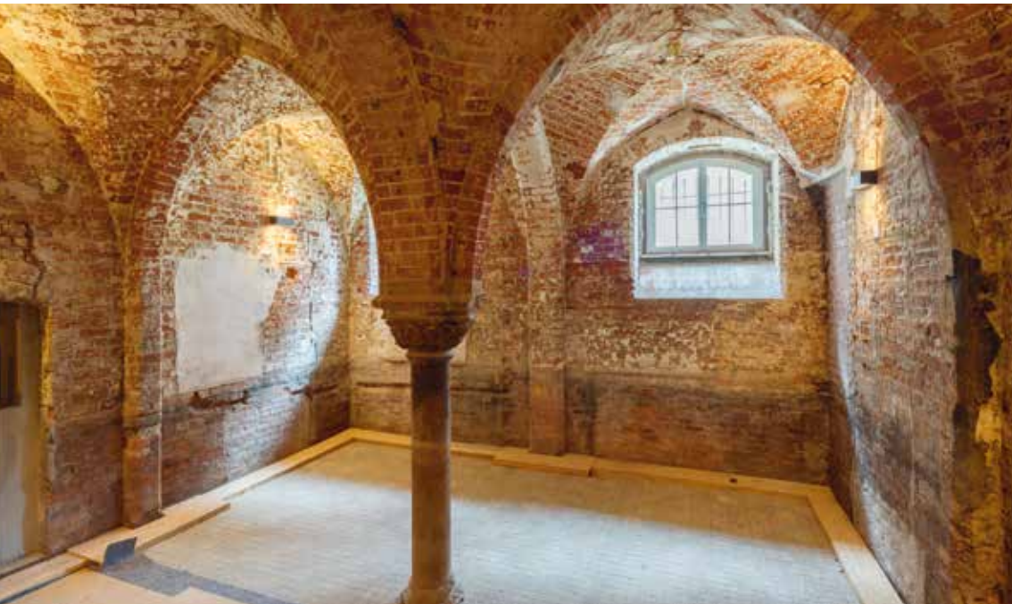
Der Säulenraum im Keller des Hauses
