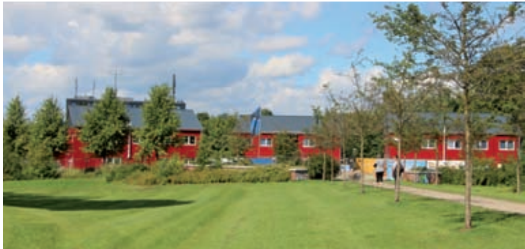
Die neue Flüchtlingsunterkunft am Holmbrook entstand für 208 Menschen auf dem Dach des A7-Tunnels
