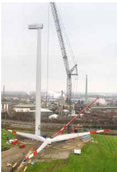
AUF DEM ENERGIEBERG WIRD DER FERTIGE ROTOR AN DER GONDEL MONTIERT. HAMBURG ENERGIE PLANT 2015 DEN BAU VON WEITEREN SECHS ANLAGEN DIESER GRÖSSE IM HAMBURGER HAFEN.
