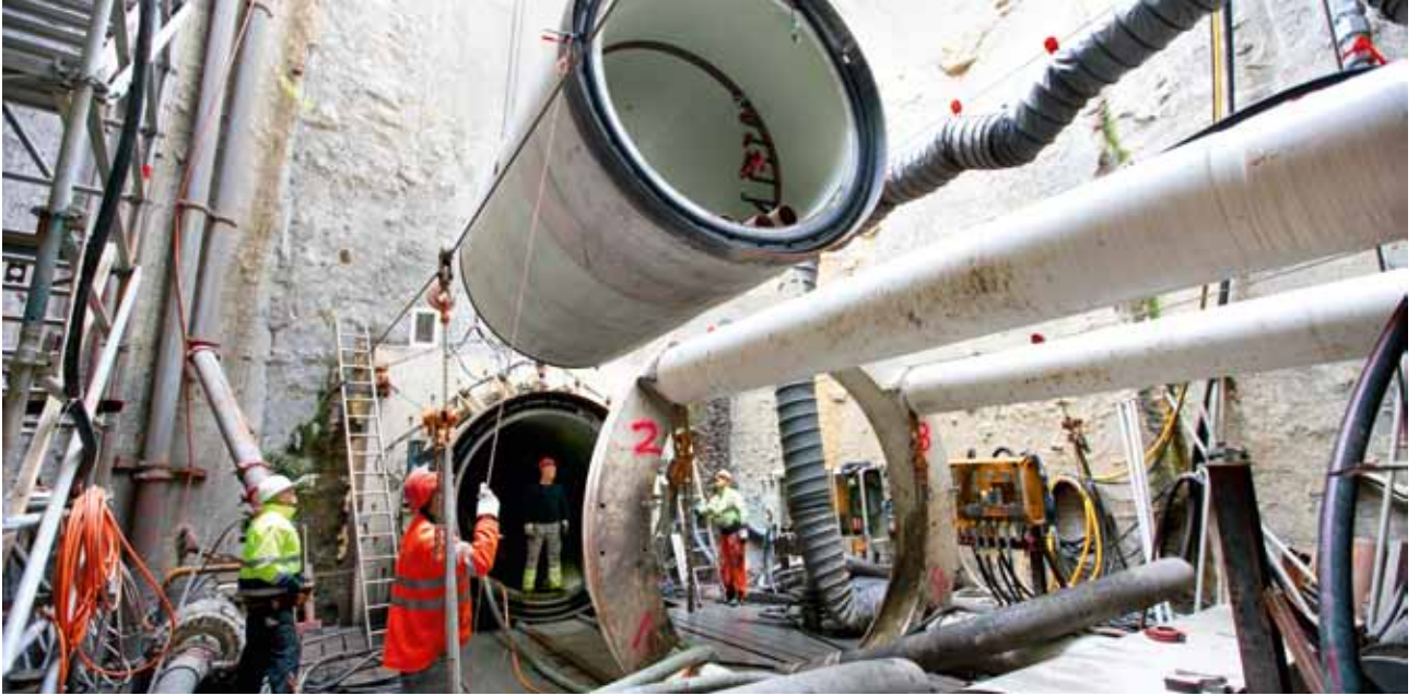
ROHRWECHSEL: EIN 32 TONNEN SCHWERES SIELELEMENT WIRD IN DIE BAUGRUBE ABGELASSEN.
