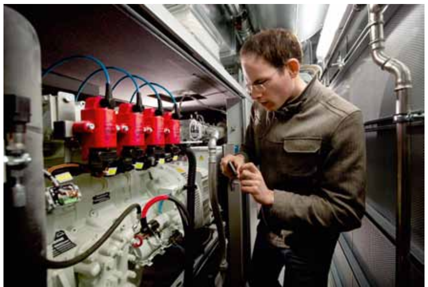
DAS HERZ DES BHKW: EIN HOCH-EFFIZIENTER GASMOTOR.
