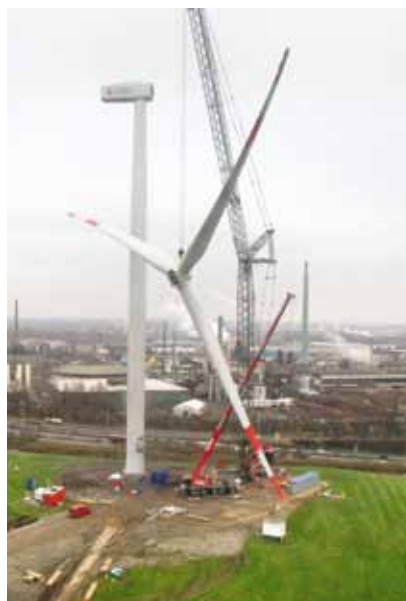
AUF DEM ENERGIEBERG WIRD DER FERTIGE ROTOR AN DER GONDEL MONTIERT. HAMBURG ENERGIE PLANT 2015 DEN BAU VON WEITEREN SECHS ANLAGEN DIESER GRÖSSE IM HAMBURGER HAFEN.
