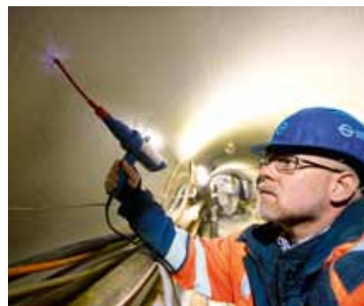
ALLES DICHT? CHRISTOPHER RUDLAFF ÜBERPRÜFT DIE SCHWEISSNÄHTE DES NEUEN TRANSPORTSIELS MITHILFE EINES FUNKENBESENS.
