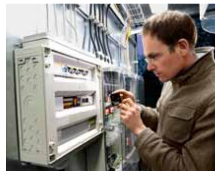
DER BLICK AUF DEN LAUFENDEN ZÄHLER VERRÄT: HIER WIRD STROM FÜR DIE ANWOHNER PRODUZIERT.
