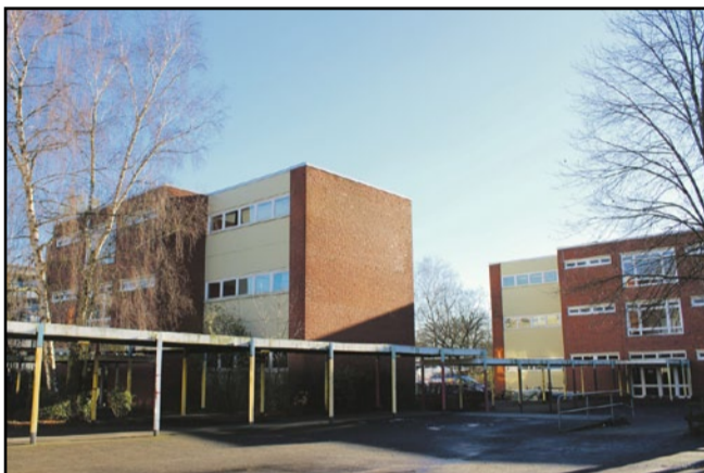
Im August wurde die ehemalige Schule in der Billwerder Straße mit 60 Plätzen in Betrieb genommen. Nach dem umfangreichen Umbau können hier ab Januar rund 200 Betreute leben.
