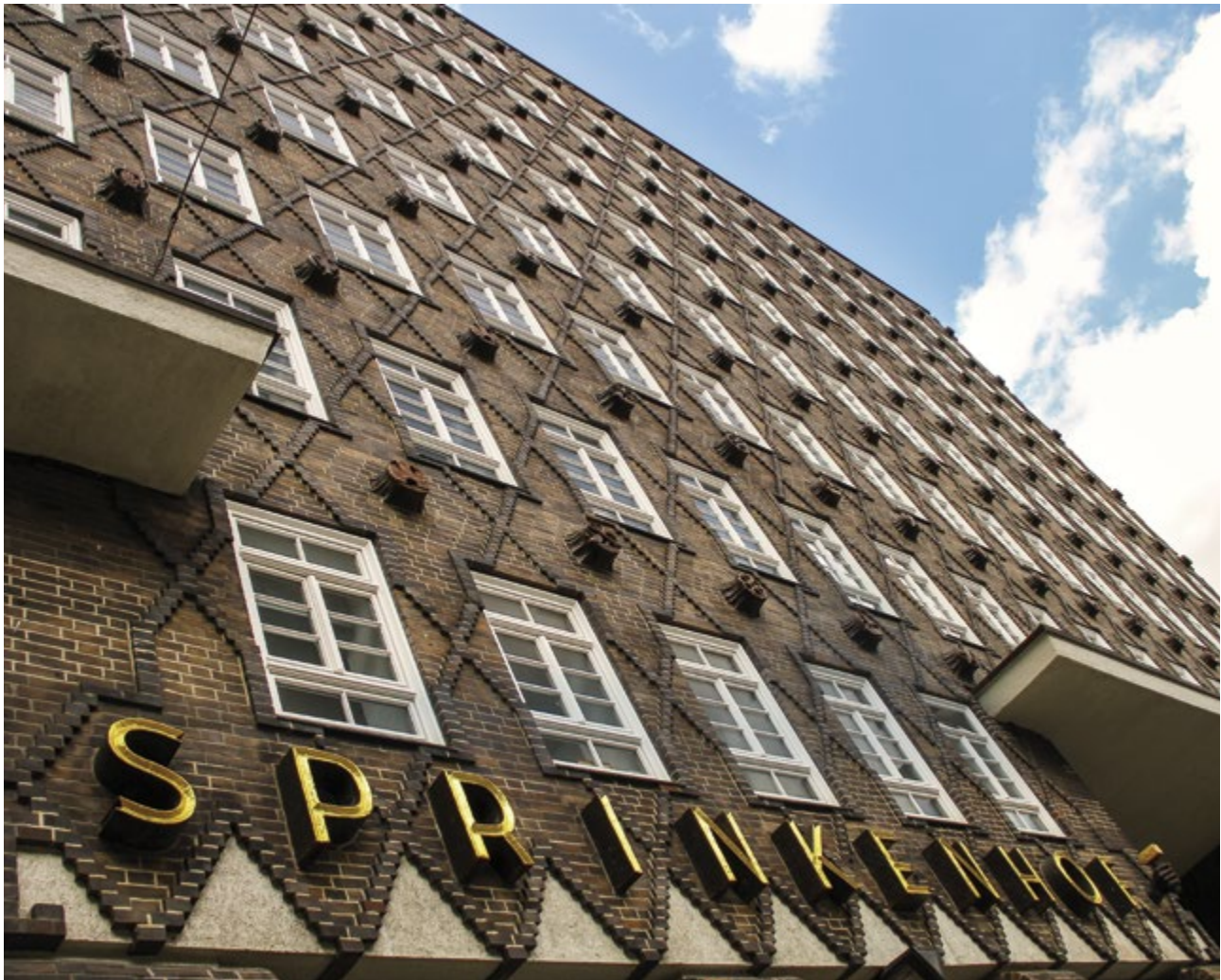
Fassadenpartie des Sprinkenhofes.
