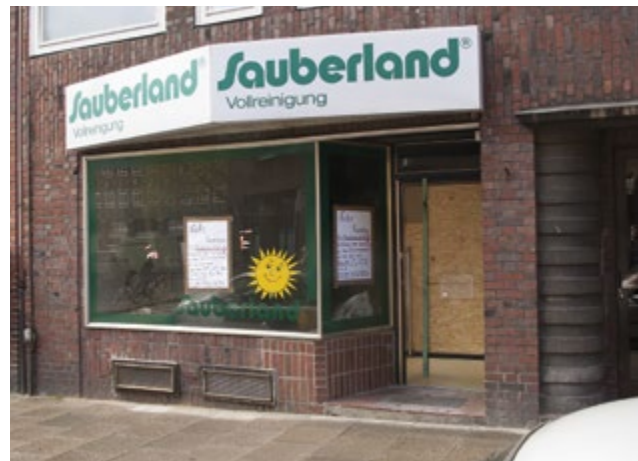
Wegen Brandschadens nach nebenan gezogen – aber der Betrieb geht weiter.
