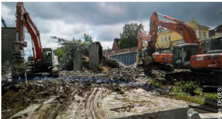
Brückenabbruch im Sommer für den Schnelsener Lärmschutztunnel
