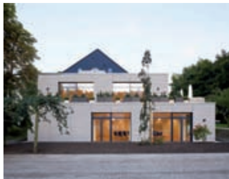
Anbau am Haus Rissen
