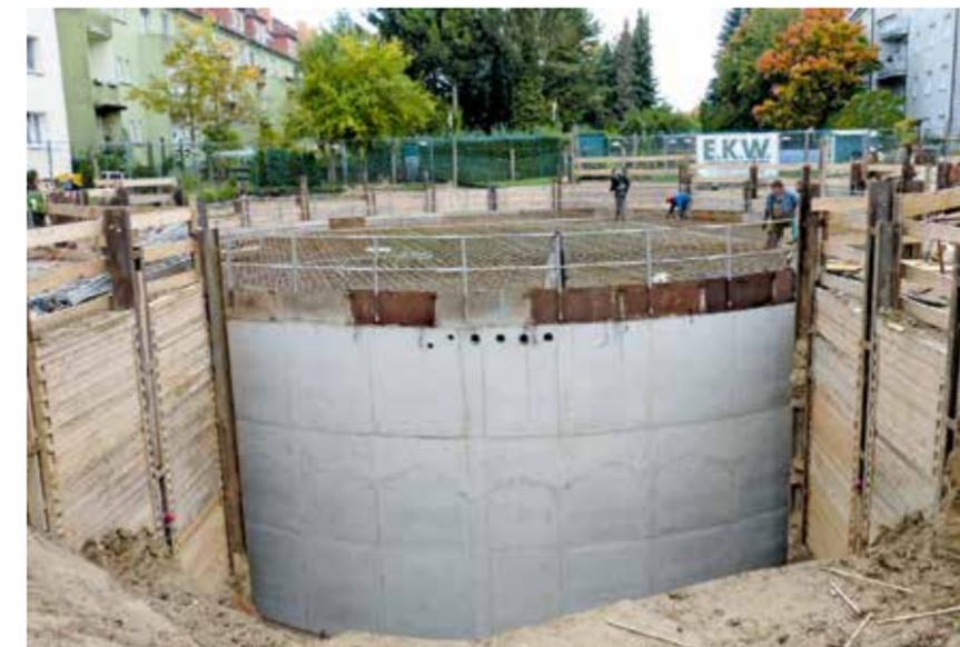
Der größte Eisspeicher Hamburgs, sechs Meter hoch mit einem Durchmesser von 20 Metern, liefert Energie für 477 Wohnungen. Für ihr ganzheitliches Konzept der Gebäudesanierung erhielt der Eisenbahnbauverein Harburg den ersten Preis.
