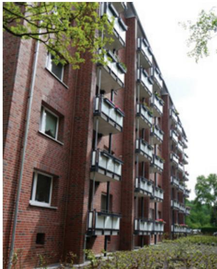
Die vorhandenen maroden Balkone wurden durch neue, um etwa ein Drittel größere „Vorstell-Balkone“ ersetzt. Auch die Eingangssituationen zu den Gebäuden wurden verändert. Die Vorbauten wurden durch Vordächer ersetzt. Zusätzlich zu den Eingangsstufen wurden Rampen geschaffen, um den Zugang für ältere Mieter sowie Eltern mit Kinderwagen zu erleichtern.
