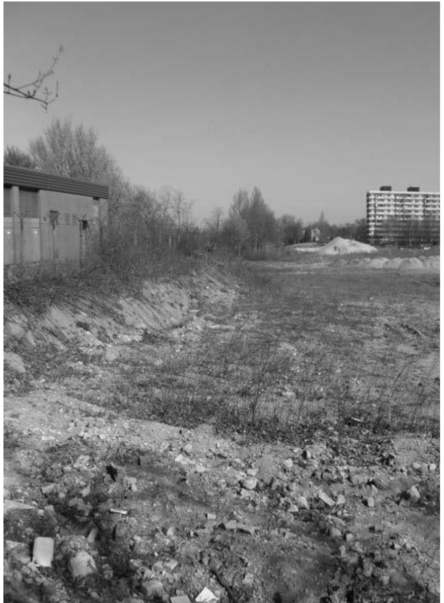
Wilhelmsburg als Mega-Baustelle.
