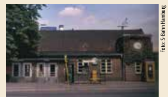
Mit Eröffnung der S-Bahn nach Neugraben hatte der alte Bahnhof Unterelbe ausgedient.
