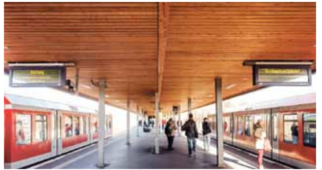
Das Dach des Bahnhofs Veddel ist im Jahr 2010 mit witterungsbeständigem Lärchenholz verkleidet worden.
