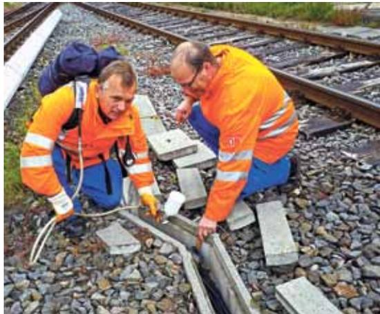
Richard Stepien (links) und Domenico Le Piparo markieren Kabel mit künstlicher DNA, die mittels UV-Licht sichtbar wird.
