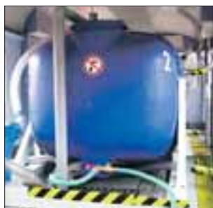
11 600 Liter Wasser passen in einen Wassertank.
