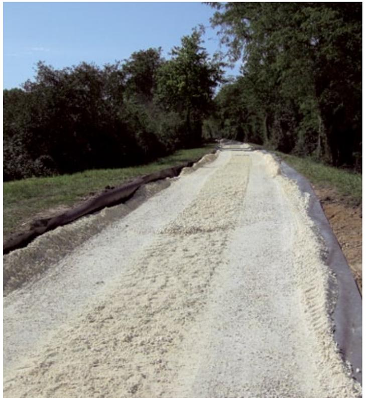
Durchlässig, chemisch unschädlich und in großer Breite erhältlich ist der DuPont™ Plantex® root protector insbesondere für horizontale Anwendungen wie Radwege geeignet.
