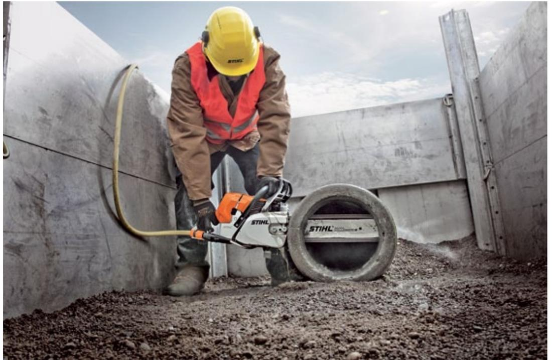
Für ruhiges und vibrationsarmes Nass-Trennen von Baumaterialien entwickelt, sind die neuen Diamantketten 36 GBM und 36 GBE von STIHL die ideale Ausrüstung für Gesteinschneider. (Foto: STIHL)
