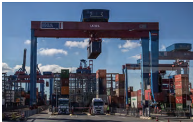
Lkw-Abtransport am nördlichen Ende der Blocklager
