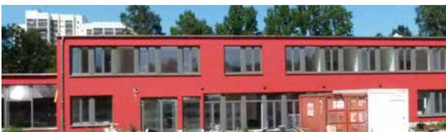
Bürgerhaus kurz vor der Fertigstellung 2013
