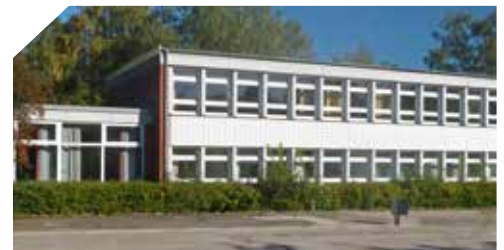
Schule am Barls vor dem Umbau
