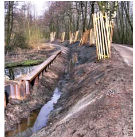
Neues Düpenaubachbett am Schacksee
