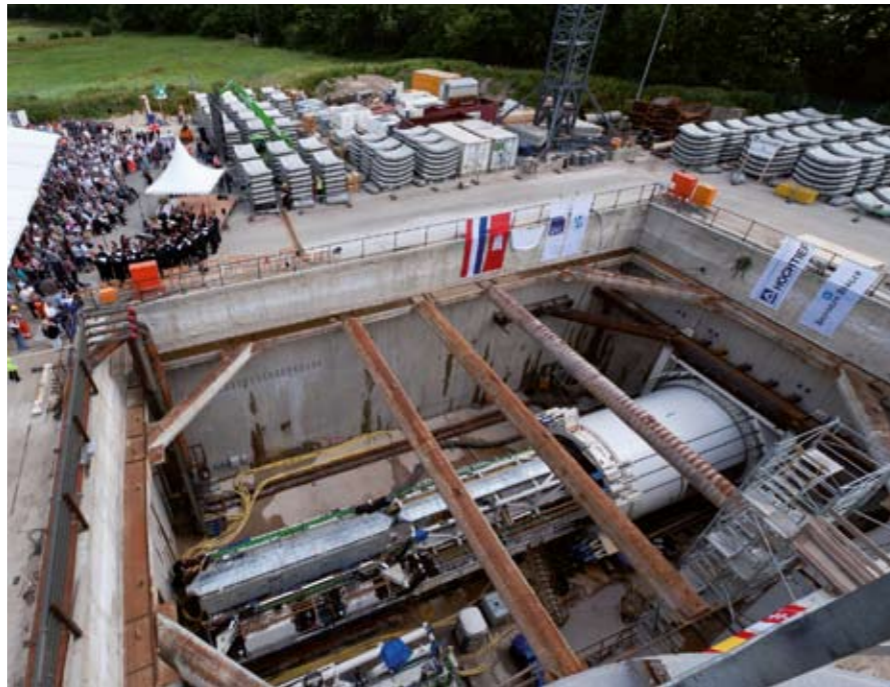
Tunnelfest am 30. Juni 2010 auf der Baustelle Schenefeld (Fotos: European XFEL)
