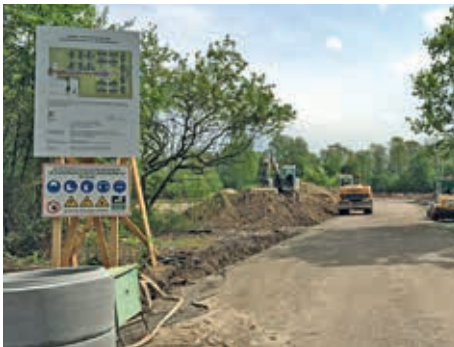
Bauarbeiten in der Grunewaldstraße
