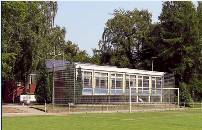
Das Clubhaus des TSV Wandsetals wurde 1976 ausgebaut. In dieser Zeit wurde auch eine Tennisanlage im Sportpark Hinschenfelde eröffnet. Fotos: Thorsten Richter
