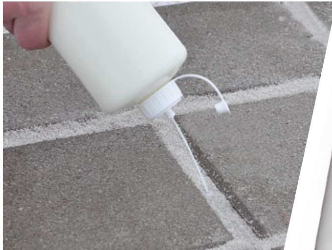
(Foto: Nadler Straßentechnik GmbH)
