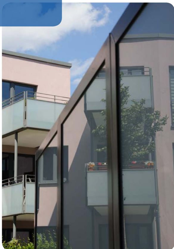
Neubau Treттаstraße 7-11, 11 a-c in 21107 Hamburg, VE 3201
