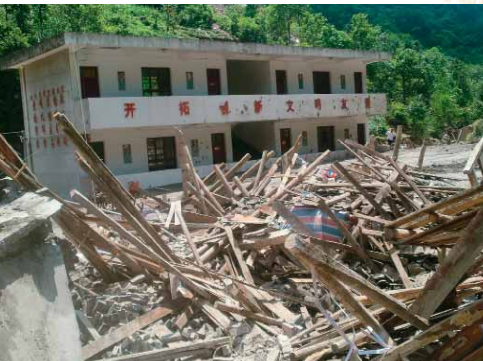
Schulen und Latrinen müssen nach den Erdbeben wiederhergestellt werden.
