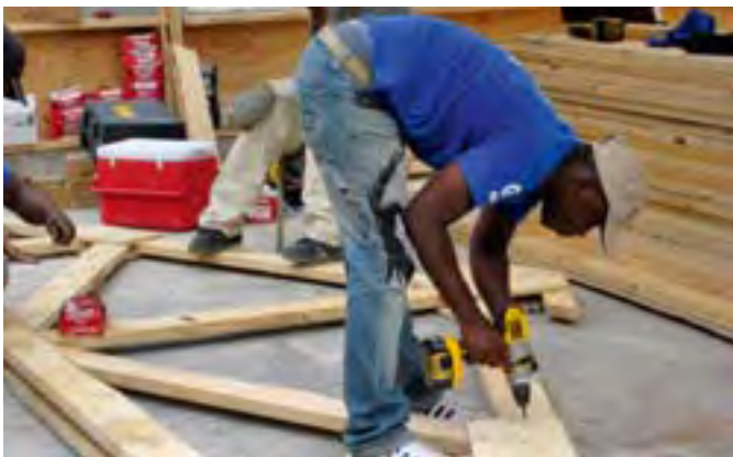
150 Übergangsschulen hat Plan bereits in Haiti errichtet, weitere 144 provisorische Schulen werden zurzeit mit Gemeindegliedern gebaut.
