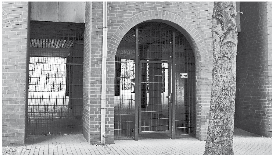
Der vergitterte Durchgang am Willi-Hill-Weg
