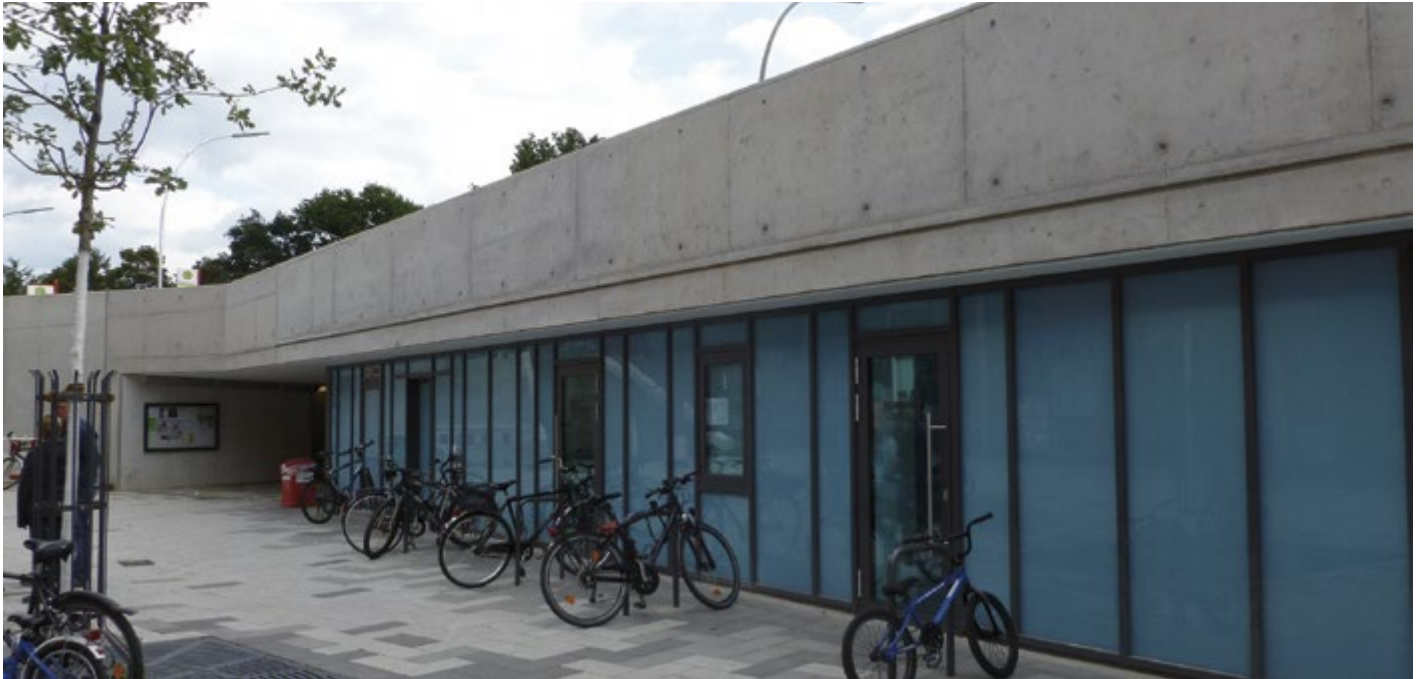
Das Marktbüro ist in die Treppenanlage integriert.
