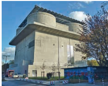
Die IBA hat dem altem Klotz zu neuer Energie verholfen (Foto:dn)
