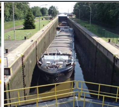
Das Aussteigen über Leitern aus der Schleusenammer wird sicherer.
