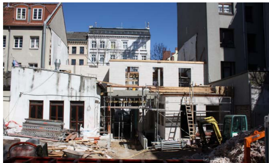
Blick vom Innenhof auf die Bauarbeiten
