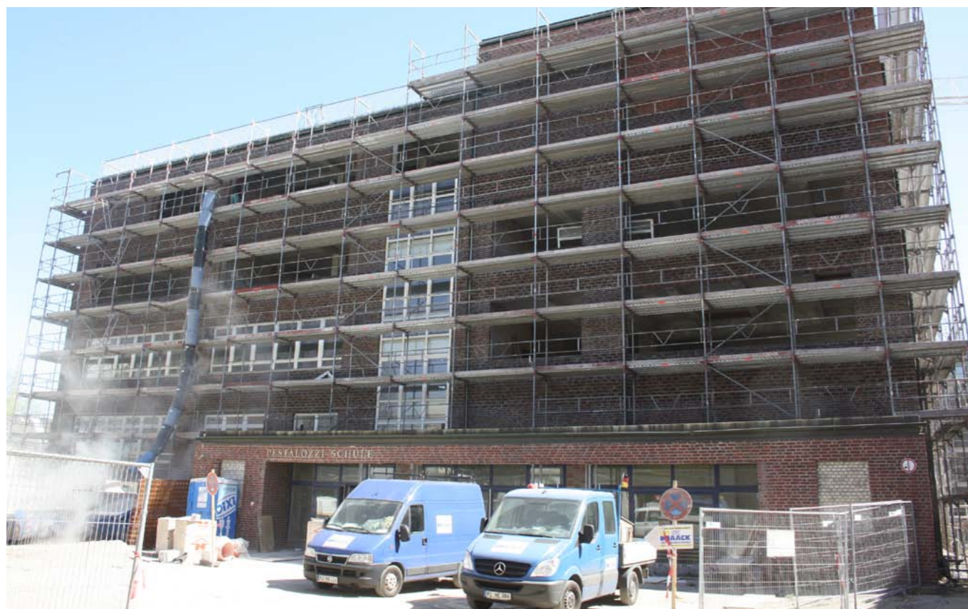
Das Hauptgebäude der Schule wird zu Wohnen umgebaut
