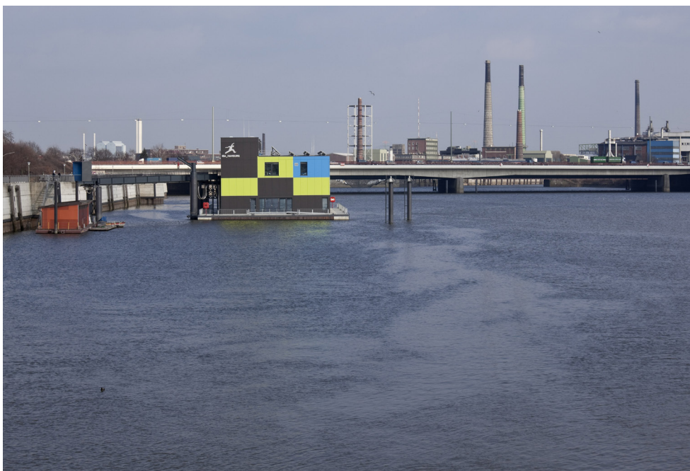
Abb. 2: IBA DOCK in der Metrozone Müggenburger Zollhafen (Westansicht)
