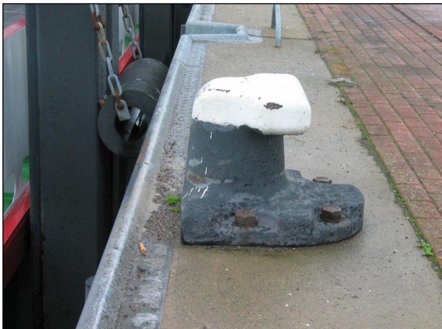
Abbildung 9: Kaikante mit Poller, Dalben und Fender
